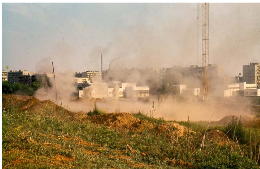
Фиг. 7.8. Изглед на площадката по време на взривяване на дълбочинните заряди. Отделя се голямо количество газ, който играе важна роля за бързото уплътняване. Под високо налягане той се смесва с водата, понижава нейния вискозитет и ускорява консолидацията.
