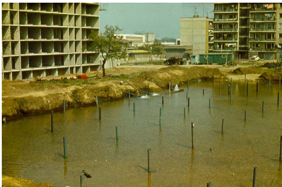
Фиг. 7.7. Уплътняване чрез повърхностно и дълбочинно намокряне на основата
