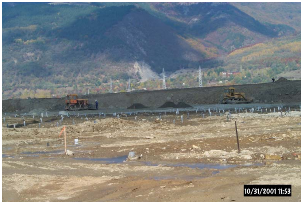
Фиг. 5.6. Ефект от уплътняването с полимерни лентови дренажи (а) – Наводняване на повърхността с вода от дренажите ;на преден план се виждат ролата с полимерни ленти; (б) – Рекултивация на терена след уплътняването; момент от изграждането на насипа; (Фото инж. геолог Б. Калчев)
