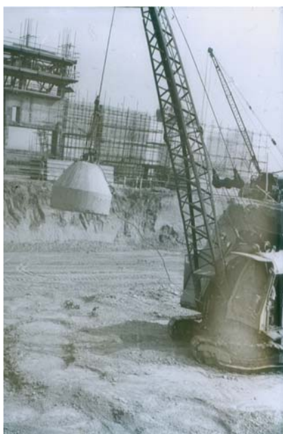
Фиг. 4.1. Уплътняване на с 2,5 тонна трамбовка на льосовата основа на I енергоблок на АЕЦ “Козлодуй”
