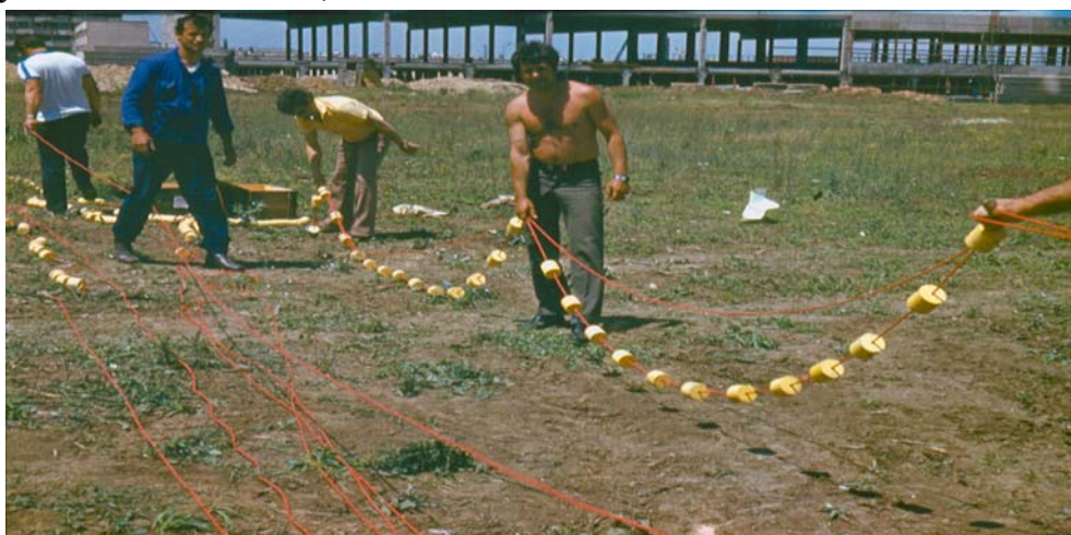
Фиг. 4.8. Линеен заряд от тротилови пресовки, нанизани на детониращ шнур, който се спуска в сондаж
