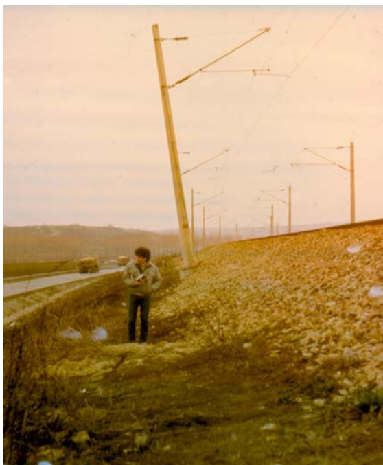
Фиг. 3.4. Удебелена баластрова призма вследствие на слягане на неуплътнен насип по жп-линията Дралфа-Търговище.
