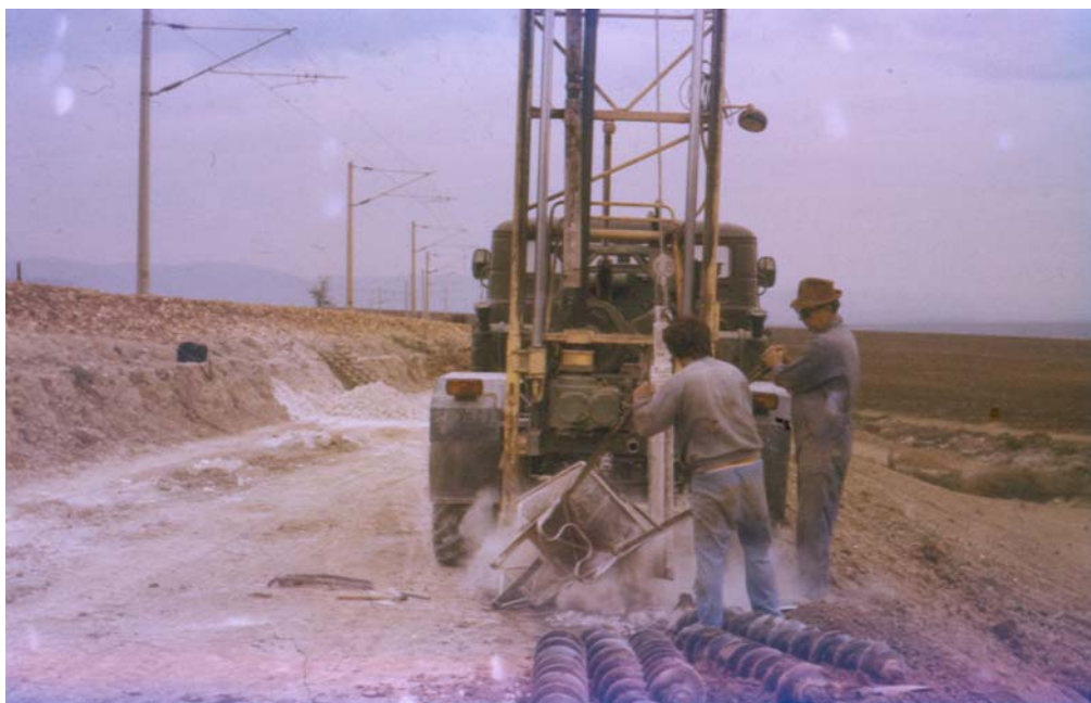
Фиг. 24.5. Насипване на негасена вар в сондажа. Насипването се извършва на порции от по една количка, като всяка порция се уплътнява до отказ с трамбовката
