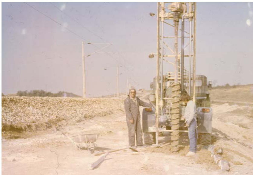
Фиг. 24.4. Пробиване на сондажните отвори със шнек
