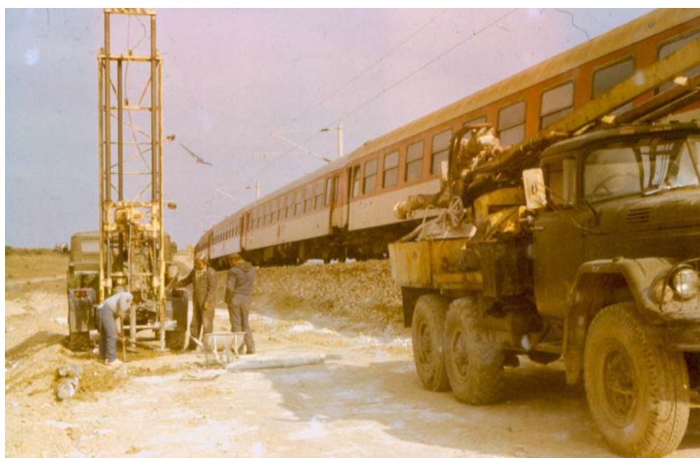
Фиг. 24.6. Момент от уплътняването на варта в сондажа Вижда се преминаващ влак по нетретираната част от насипа
