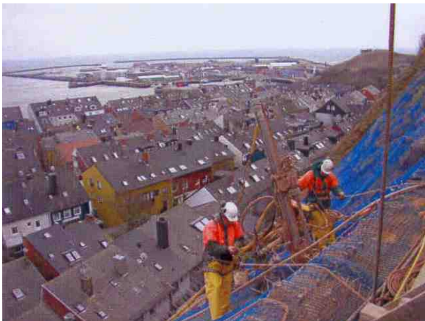
Фиг. 22.8. Защита на сгради от падащи камъни чрез мрежа “закована” за склона с къси метални анкери: а – принципна схема; б – момент от изпълнението(по проспект на фирмата Geobrugg)
