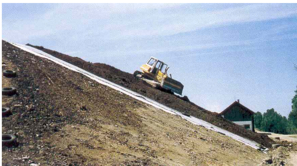
Фиг. 22.8. Полагане на геокомпозитна мембрана
