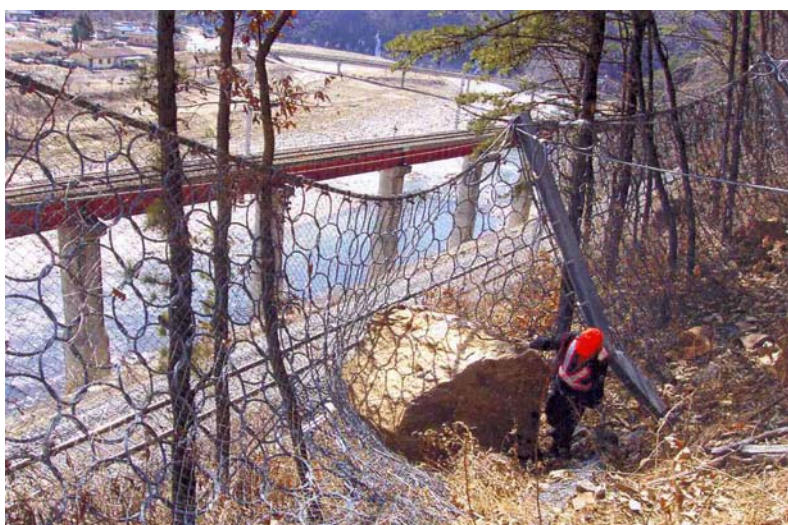
Фиг. 22.9. Задържане на голям камък, паднал от стръмен склон над ж.п. линия (по проспект на фирмата Geobrugg)
