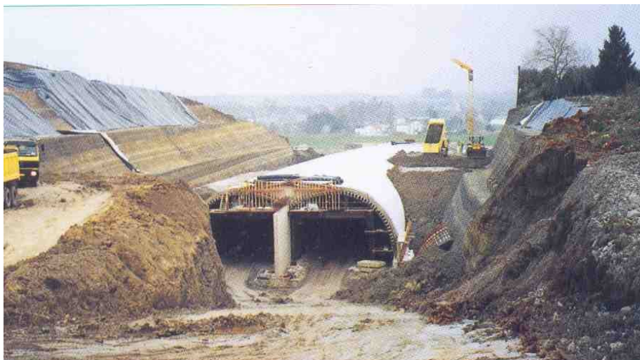
Фиг. 22.6. Приложения на геомембрана: 22.6 а,б – за водоизолация на воден басейн и 22.6.в – за изолация на тунелна облицовка (по проспекта на фирмата GSE)
