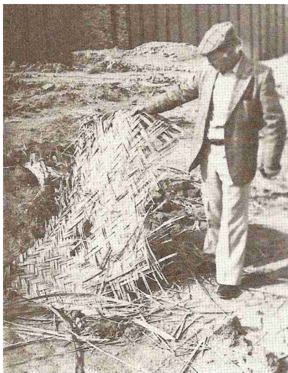
Фиг.2.6. Армиране на основа на насип върху слаба почва с рогозки от тръстика , използвано от древните шумери (Kerisel, 1985г)
