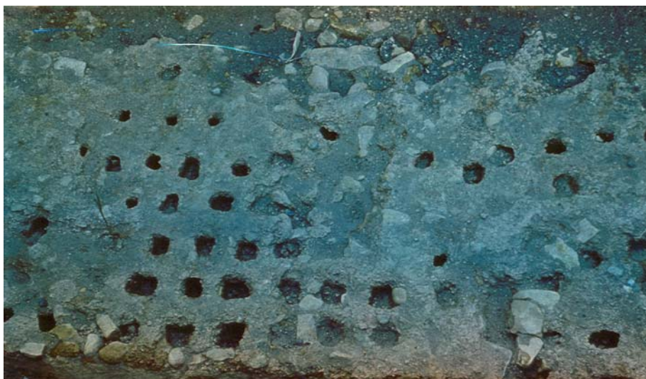
Фиг.2.4. Уплътняване на лъоса под фундаментите в Плиска с дървени колове, чийто горен край е залят с варо-пясъчна смес
