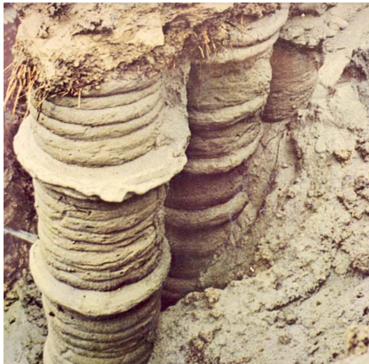
Фиг. 19.3. Изглед на разкопани колони от циментопочва след тяхното втвърдяване
