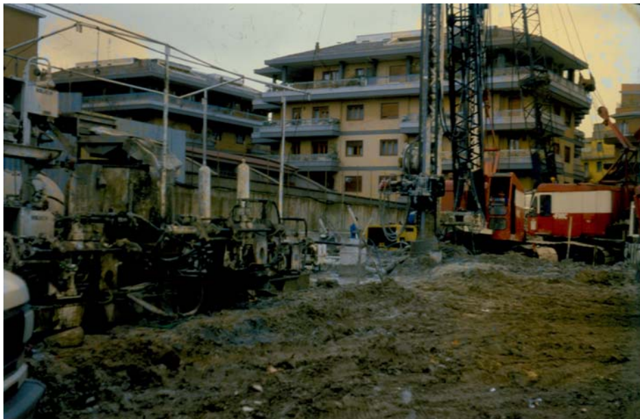
Фиг. 19.1. Изглед на строителна площадка, на която се изпълнява хидроструйно здравяване
