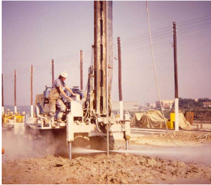
Фиг. 19.2. Изглед на уредба за хидроструйно заздравяване. Виждат се уредбата със сондажната мачта, сондажната колона и монитора, през дюзите на който излиза под високо налягане циментова суспензия.
