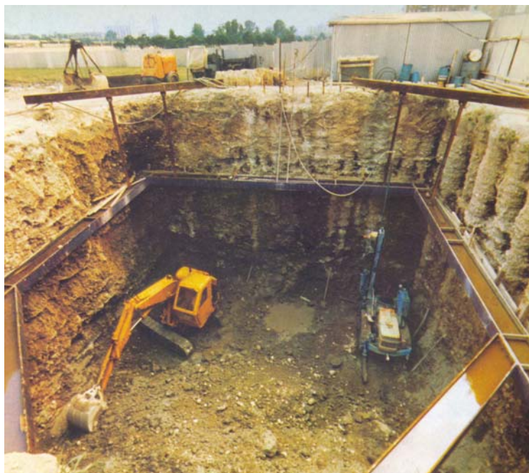
Фиг. 19.4. Укрепване на стените на шахта посредством застъпващи се циментопочвени колони
