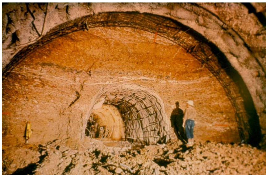
Фиг. 18.6. Изграждане на постоянната облицовка на тунела
