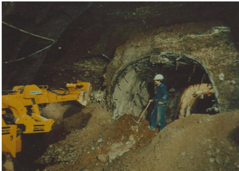
Фиг. 18.5. Прокопаване на тунел с фреза след образуване на свод от заздравена почва чрез инжектиране от пионерна галерия
