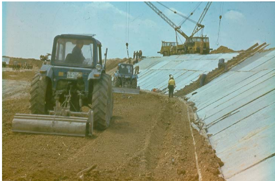
Фиг. 11.3. Момент от изграждане на циментопочвения екран на водоизравнителя при с Руманя от напоителната система “Стара Загора”
