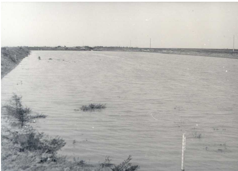
Фиг. 11.2. Уплътняване с водоналиване на пропадъчната лъсочна основа на водоизравнителя “Софрониево”. На преден план се вижда рейката за измерване на водното ниво
