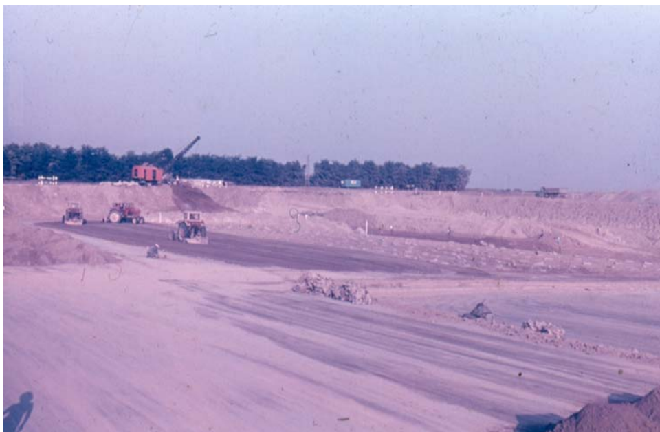
Фиг. 10.4. Изграждане на циментопочвената възглавница под I енергоблок на АЕЦ “Козлодуй”. Вижда се багера, който прави изкопа и копае почвата за възглавницата, смесването на цимента и почвата с роторна фреза и готовите циментопочвени слоеве
