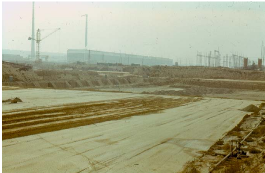
Фиг. 10.7. Изглед на циментопочвената възглавница от II енергоблок.
