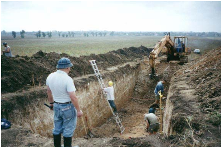
Фиг. 8.4. Изглед към канавата от север по време на изкопните работи и ръчно чистене на стените.
