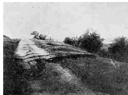
Фиг. 8.9. Нарушенията на Цариградското шосе (сега главен път Е-80) близо до Поповица показват повърхностната изява на разлома при земетресението на 18 април 1928 г. (ДИПОЗЕ, 1931).
