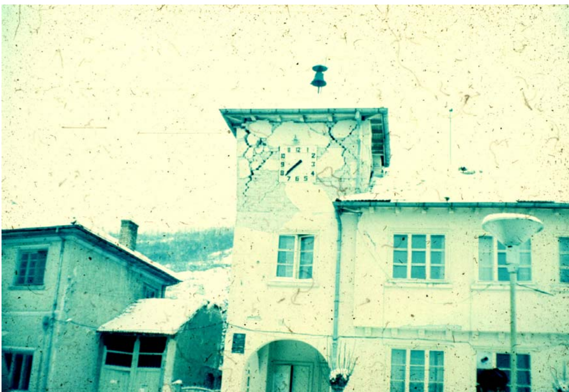
Фиг. 4.6. Напукана часовникова кула на кметството в с.Асеново (епицентър на земетресението с M=5.1 през м.февруари 1986 г. Кулата рухва при земетресението с M=5.7 през м.декември 1986 г.
