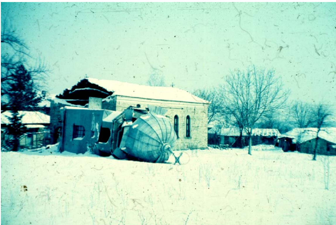
Фиг. 4.7. Разрушена камбанария на църквата в с. Мирово, Горнооряховско от земетресението с M=5.1 през м.февруари 1986 г.
