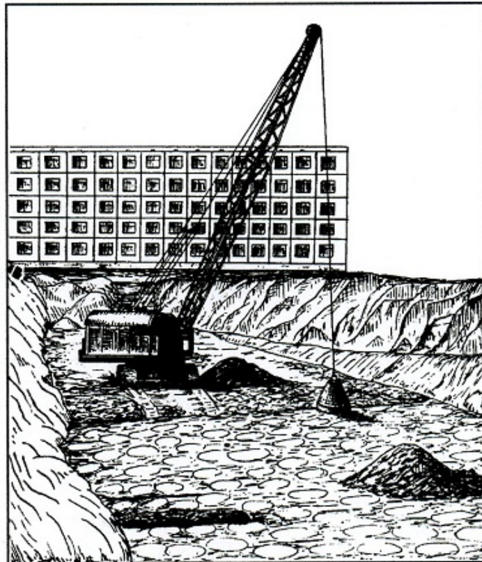
Фигура 63. Уплътняване дъното на строителен изкоп с тежка трамбовка
