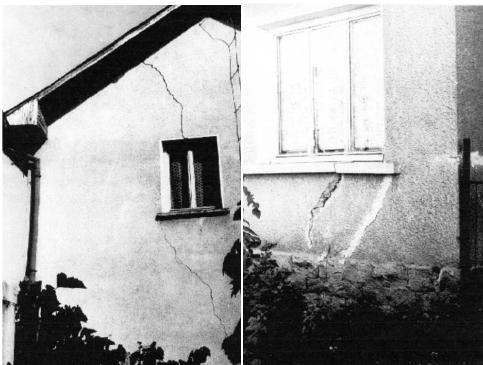
Фигура 55. Напукване на сгради в гр. Вършец в резултат на набъбване и свиване на почвите в основата им
