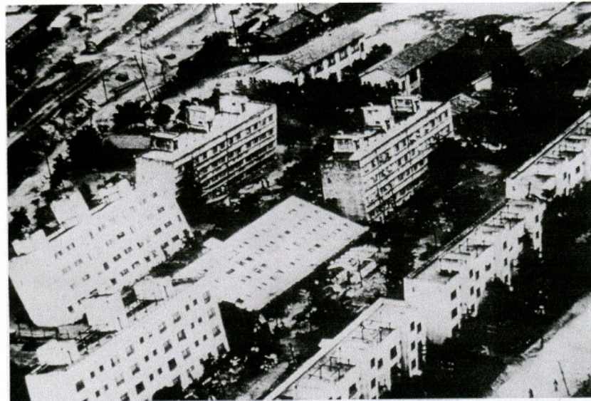
Фиг. 3. Последствия от втечняване на почви след земетресението от 1968 г. в гр. Ниигата, Япония (по USGS Photo Library, Denver, Colorado, USA)
