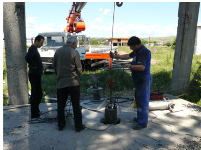
Инсталиране на потопяема помпа за първото опитно водочерпене, Май (27-28)
