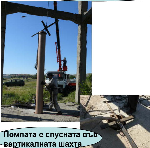
Инсталиране на потопяема помпа, поставена в PVC тръба, за второто опитно водочерпене, Май (28- 30)
