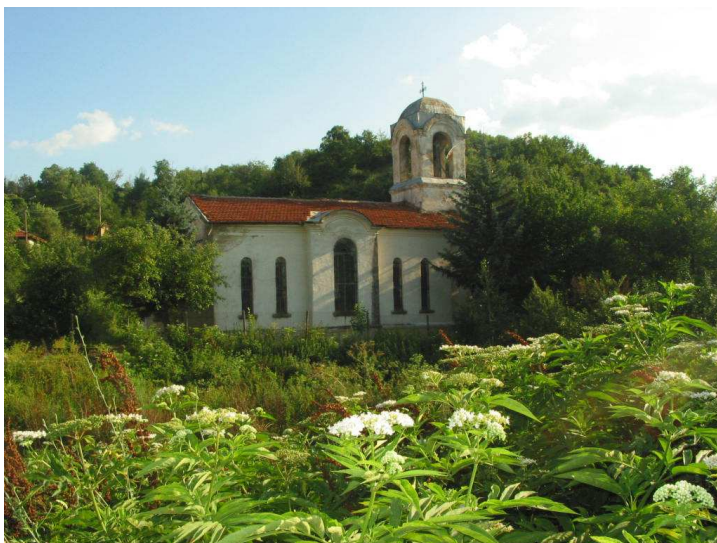
Снимка 23. Изглед на църквата от североизток.
