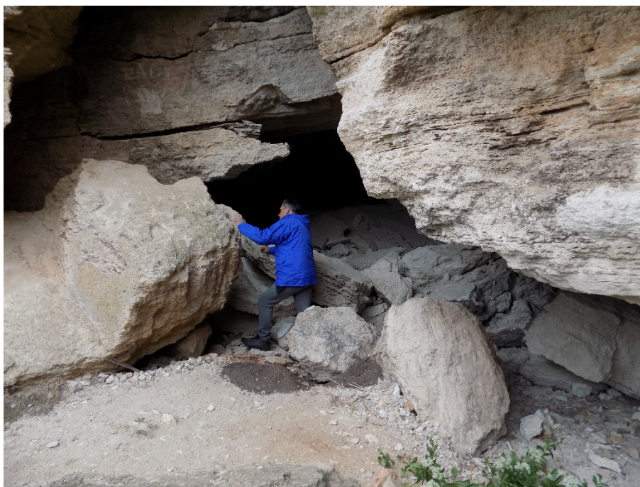
Изследване на обрушване в пещера в района на нос Калиакра
